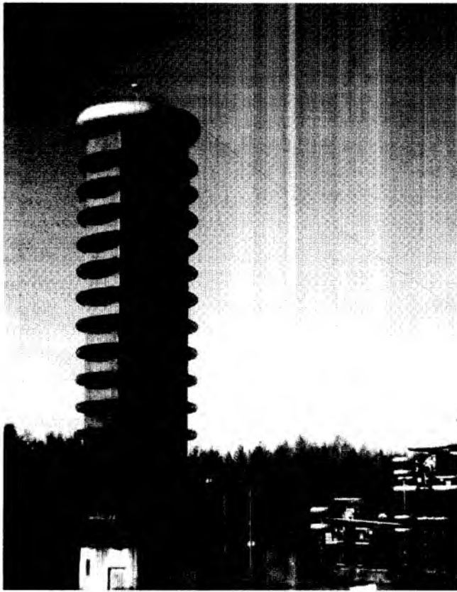
Генератор импульсных напряжений 9 МВ
