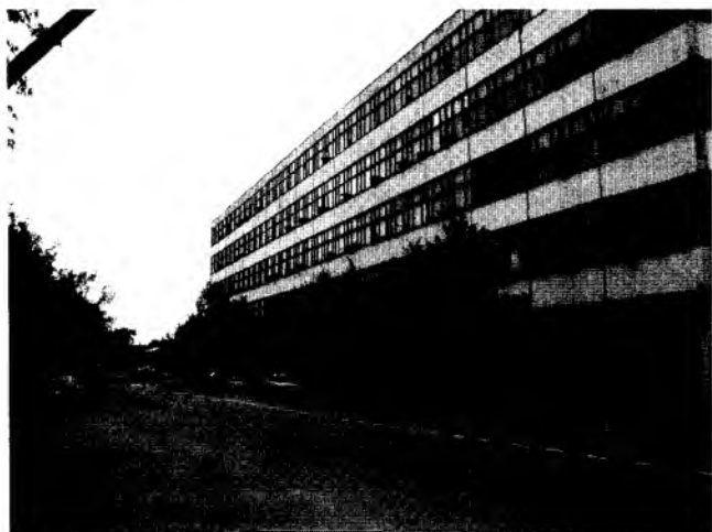
2 Корпус специальных инженерных служб
