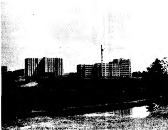
Строительство жилого микрорайона ВНИЦ ВЭИ
