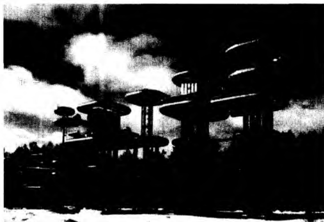
Каскад трансформаторов напряжением 3,6 МВ
